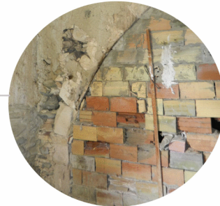
ΕΝΤΟΠΙΣΗ ΚΑΜΑΡΑΣ ΜΕΣΑ ΣΤΟΝ ΧΩΡΟ ΤΟΥ ΕΛΑΙΟΜΥΛΟΥ - ΥΠΑΡΧΗ ΔΙΧΩΡΟΥ ΠΟΥ ΕΧΕΙ ΚΛΕΙΣΤΕΙ ΜΕ ΣΥΓΧΡΟΝΑ ΤΟΥΒΛΑ ΓΙΑ ΤΟ ΔΙΑΧΩΡΙΣΜΟ ΤΟΥ ΧΩΡΟΥ
