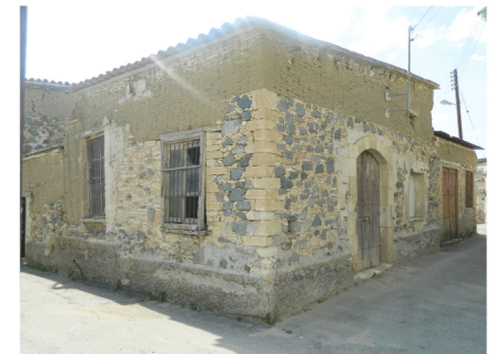
οι δύο κύριες όψεις του κτιρίου πριν την επέμβαση
