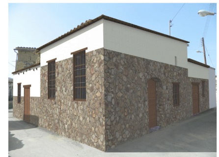
οι δύο κύριες όψεις του κτιρίου μετά την επέμβαση
